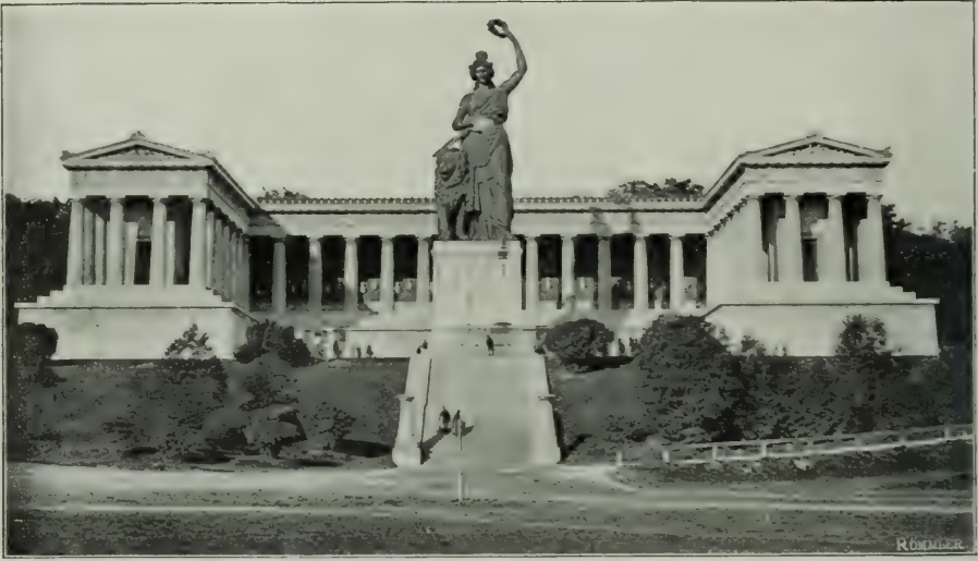
La Galerie de la Gloire ( Ruhmeshalle ) et la Bavaria .
